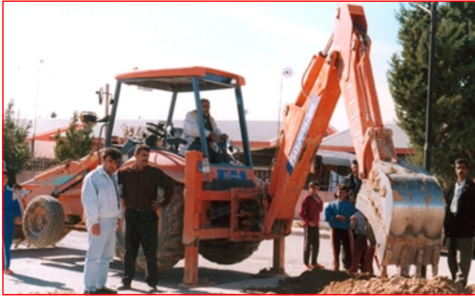
پروژهی تازهی گهرهکی زانکۆ له ههولێر
